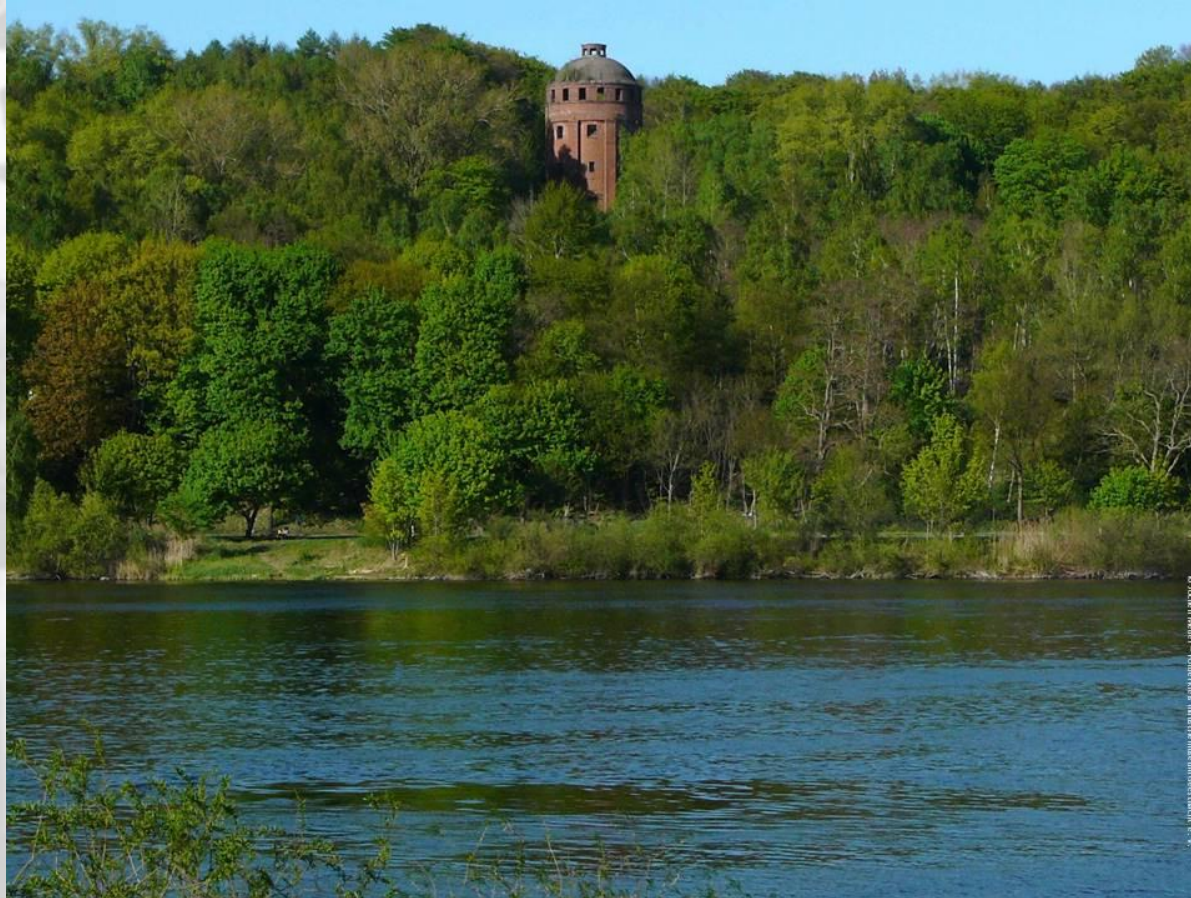
La torre d'aigua de la fàbrica de dinamita
